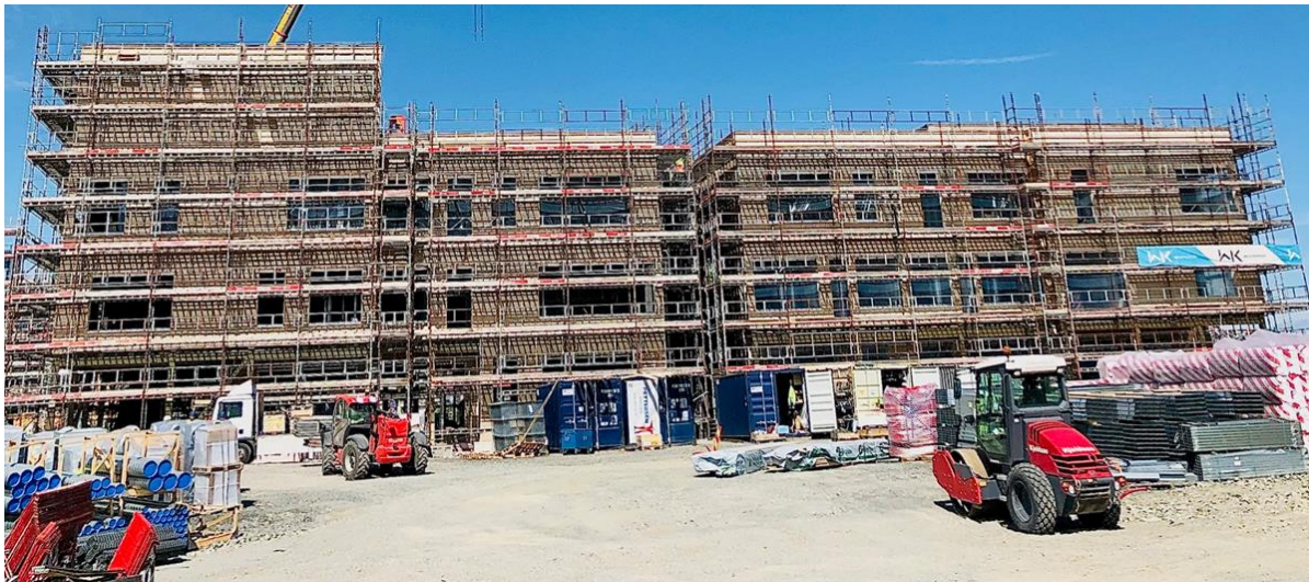
Bilde 4: Nye Klokkejordet skole under bygging, Sande. Kilde: Holmestrand kommune.
