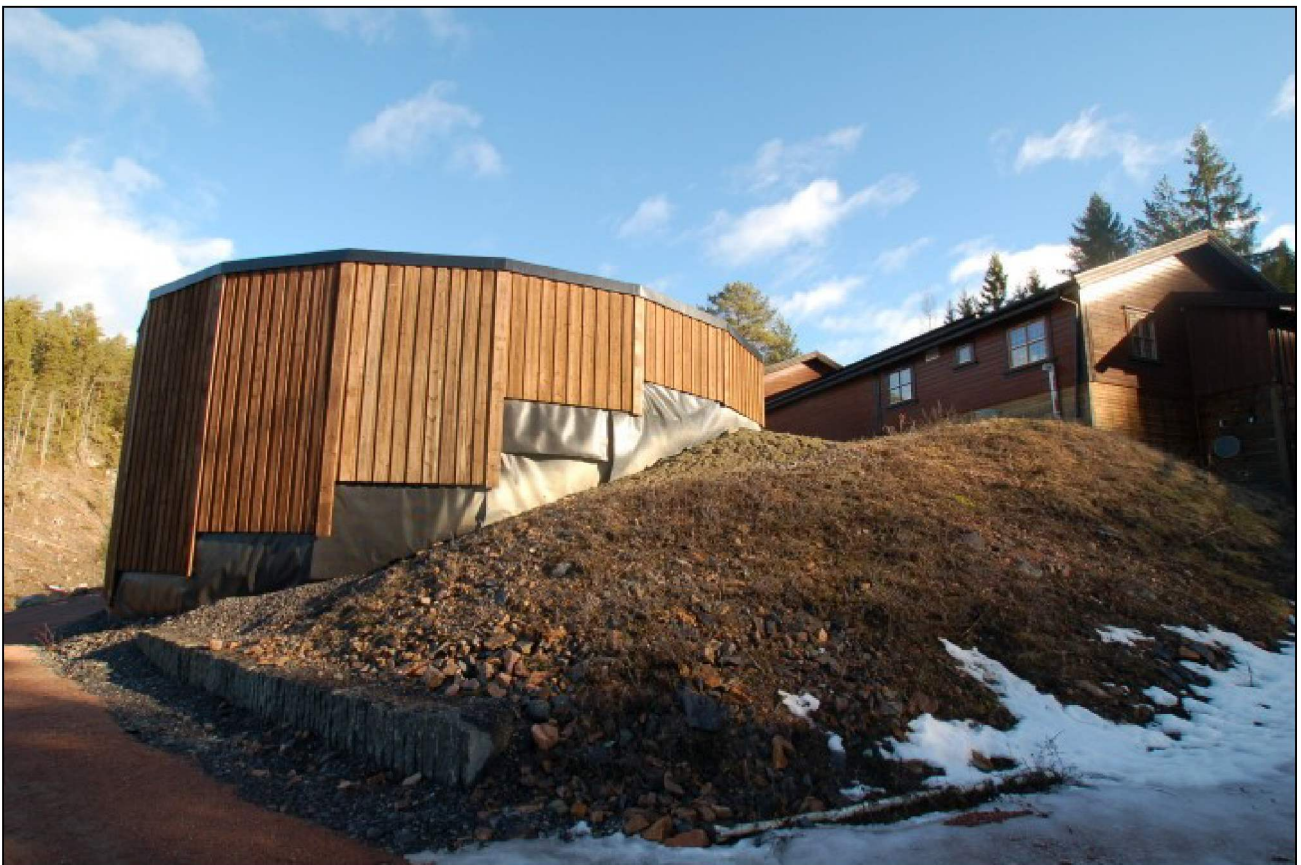
Figur 10 Røysjø vannbehandlingsanlegg (kilde Glitrevannverket).
