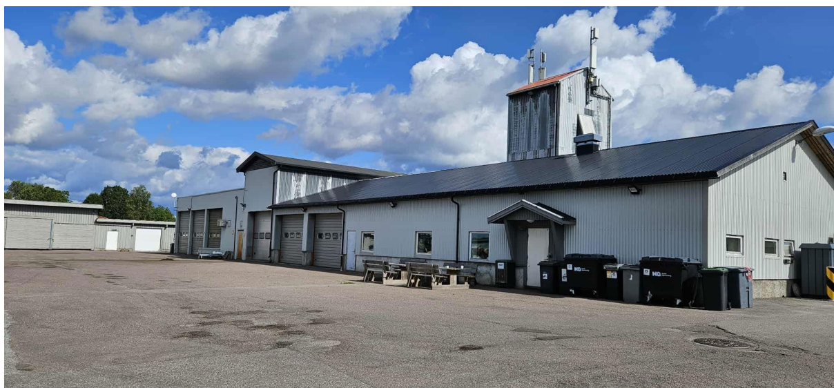
Kommunelageret i Hvitvingfossveien 127. Foto: Marisa Aasnes.
