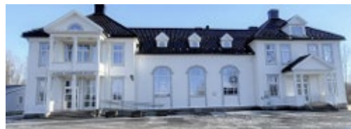
Sande kommunelokale. Foto: Holmestrand kommune
