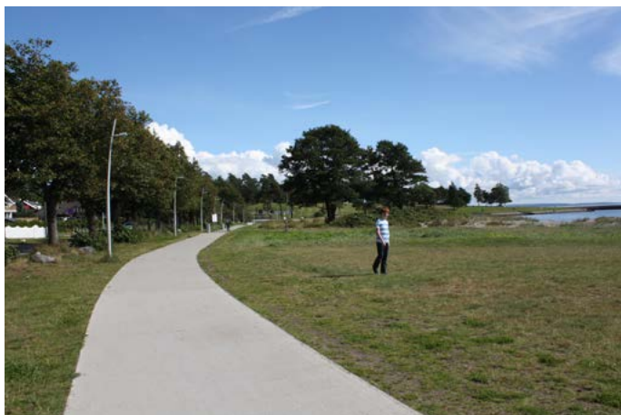
GANGVEI I PLASSTØPT BETONG, HØY KVALITET I FRIOMRÅDE
