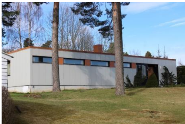
Figur 53a: Hus med aluminiumsfasade på Solåsveien i Holmestrand.
