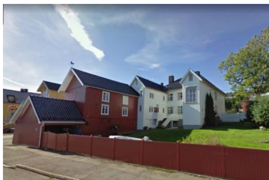
Figur 63a: Bildet viser Styregaten 7, Hegaarden fra tidlig 1700-tallet. Kjelleren er fra før brannen i 1716. Foto: Google Street View. Hentet 12.17.
