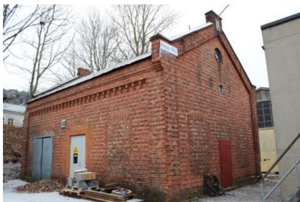
Figur 70a: Transformatorstasjonen fra 1916 var under andre verdenskrig gjenstand for sabotasje.
