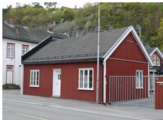
Figur 93b: Gamle politivakten. Foto: Riksantikvaren - bilde tatt i forbindelse med rapportserien "Gamle hus nå og da".
