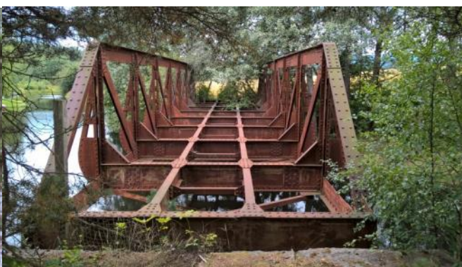
Figur 33b: Jernbanebrua i Sundbyfoss.
