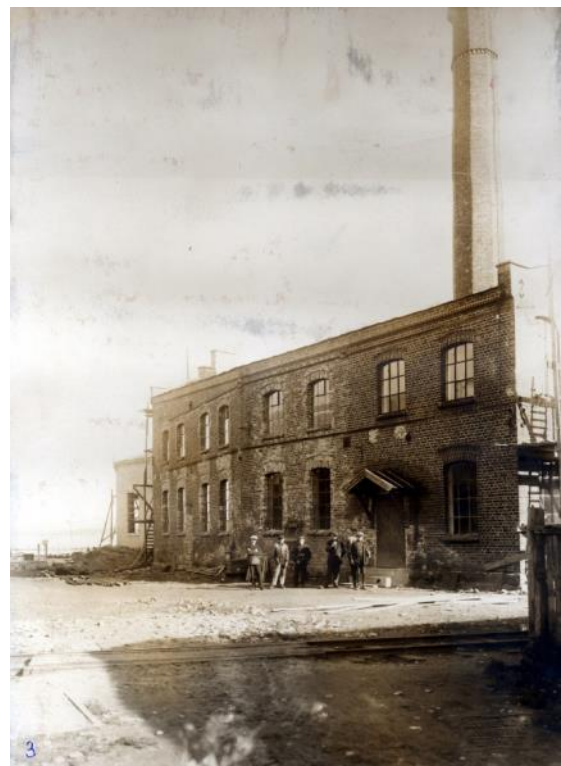
Figur 67: Sveiseverkstedet 1918. Bygningen er i dag i bruk som museum. Foto: Vestfoldmuseene.
