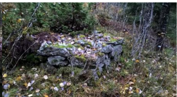
Figur 23b: Flere steder langs veien kan man se fundamentet til telefonstolpene.
