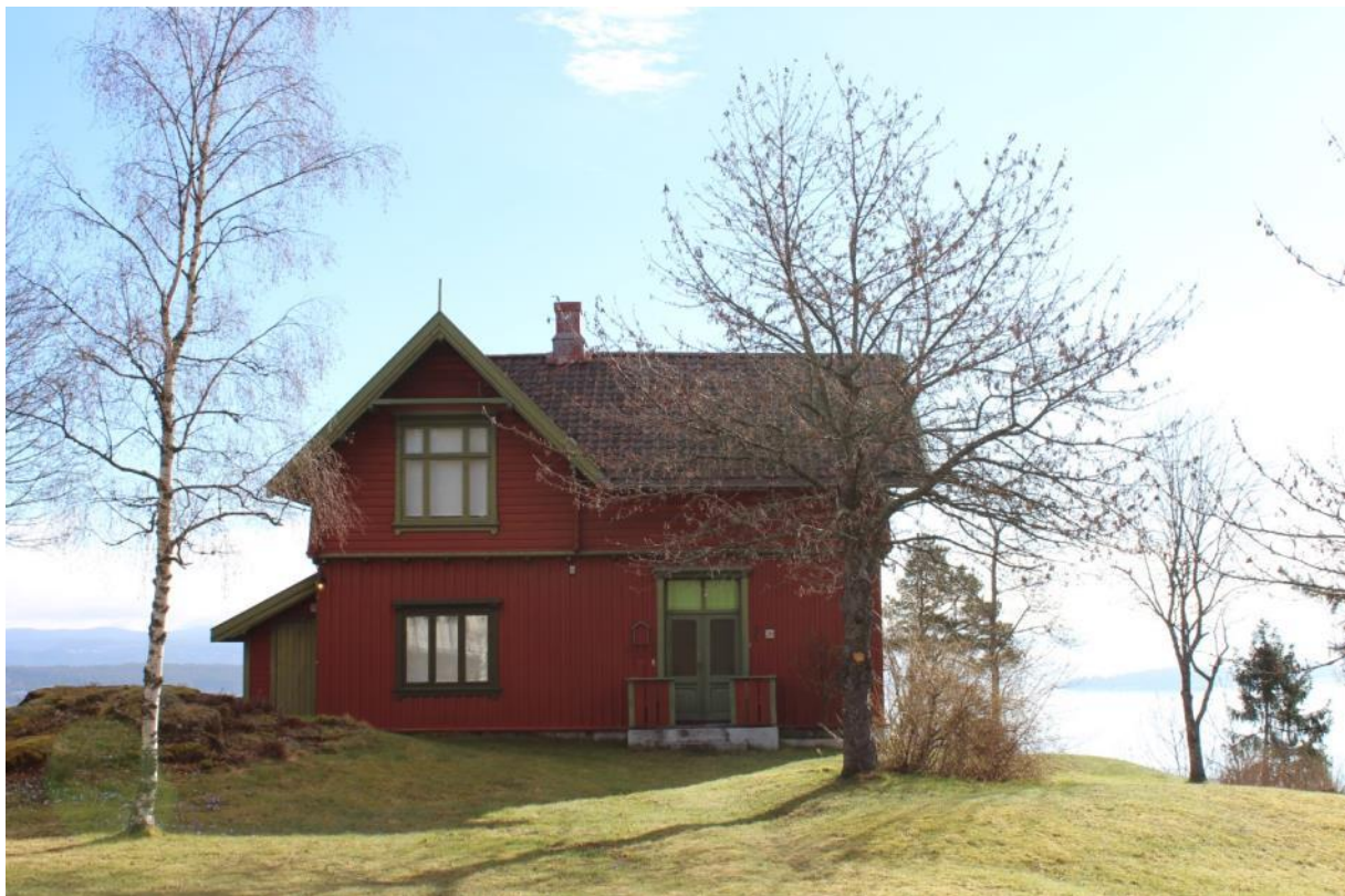
Figur 1: Hjemmet til forfatteren Olav Duun er et av flere viktige kulturminner i Holmestrand. Bygningen ivaretas som et museum av Olav og Emma Duun Stiftelsen.
