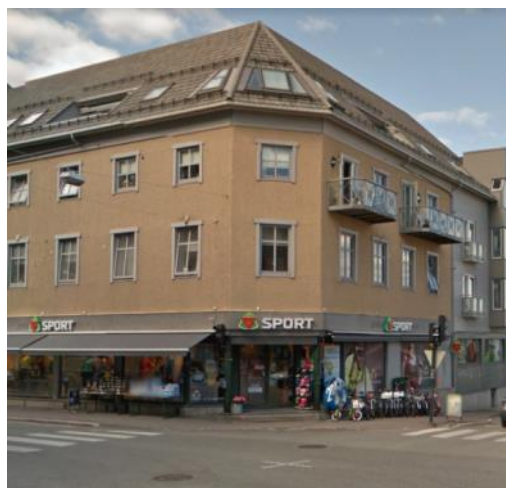
Figur 66b: Dr. Graarudsplass 1. Bygård fra slutten av 1800-tallet med modernisert fasade.
