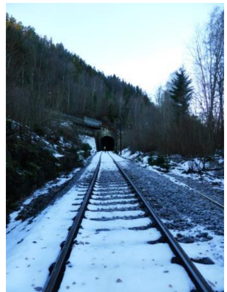
Figur 41: Smørsteintunnelen. I dag er det nedlagte sporet gjort om til turvei.
