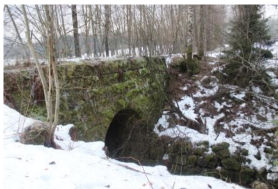
Figur 34: Jernbanebrua ved Kopstad stasjon.
