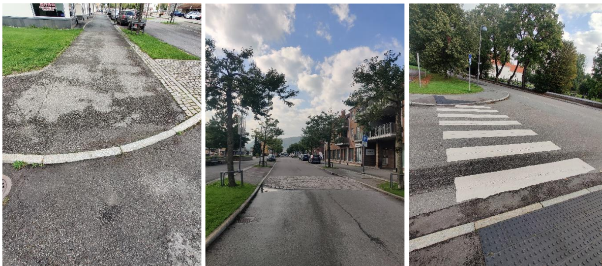
Figur 37 Venstre: nedsenket brostein på fortauskant langs Fila. Midten: Bildet tatt i sørgående retning av Fila med fortau på begge sider og markert gangfelt i brostein. Høyre: Fotgjengerovergang øverst i Bergbakken. Bildet er tatt på befaring i september 2025 av WSP.
