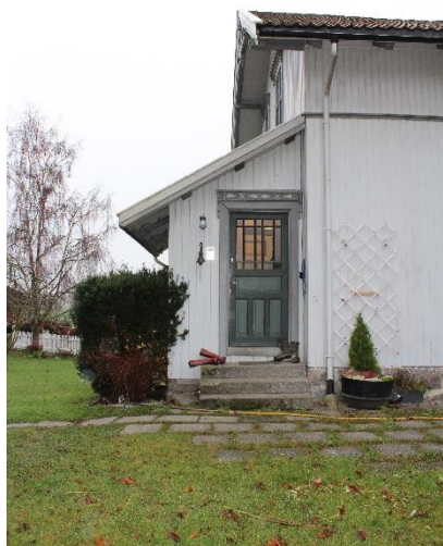
Figur 59: Huset har et lite tilbygg som er godt tilpasset husets stil.
