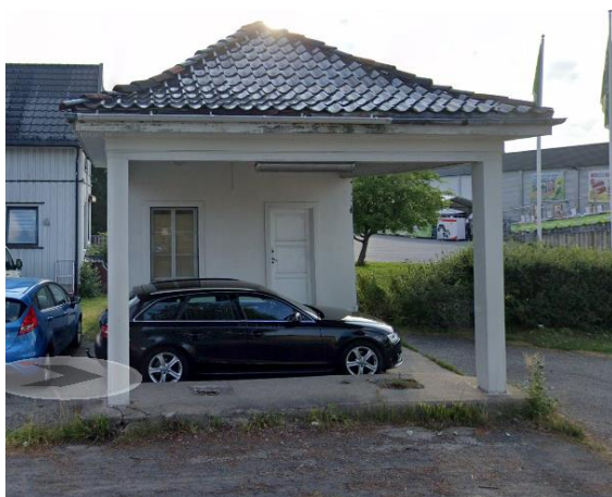
Figur 55: Den gamle Esso-stasjonen skal settes i stand i forbindelse med utbyggingene på Wingejordet. Foto: Google Street View (juli 2019).
