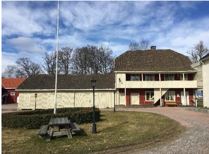
Figur 39: Sidebygningen (forpakterboligen) ved Sande gamle prestegård.
