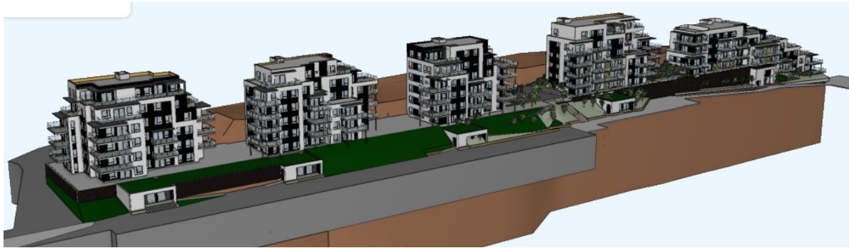
Figur 6 Bebyggelsen er plassert over en p-kjeller med grønn skråning i forkant. Inngangspartier med sykkelparkering linker p-kjeller med Bølgetoppen. (sett fra nordvest)
