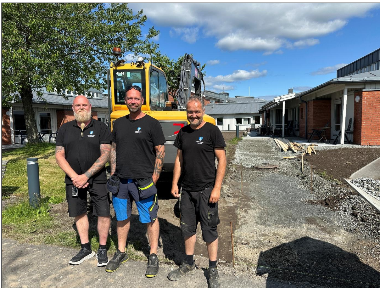
Kommunens byggdrifere har god og variert kompetanse. Bildet er fra juni 2025 da Sandetunprosjektet var helt i sluttfasen. Nye plattinger er støpt, gressplener er sådd, og beboerne kan igjen nyte kaffen ute på godværsdager. Fra venstre avdelingsleder Frode Røstvang, byggdrifter Per Magne Sæter og fagarbeider Bjørn Vegard Sire. Jobben ble langt på vei gjort i egenregi. Foto: Anitra Fossum.
