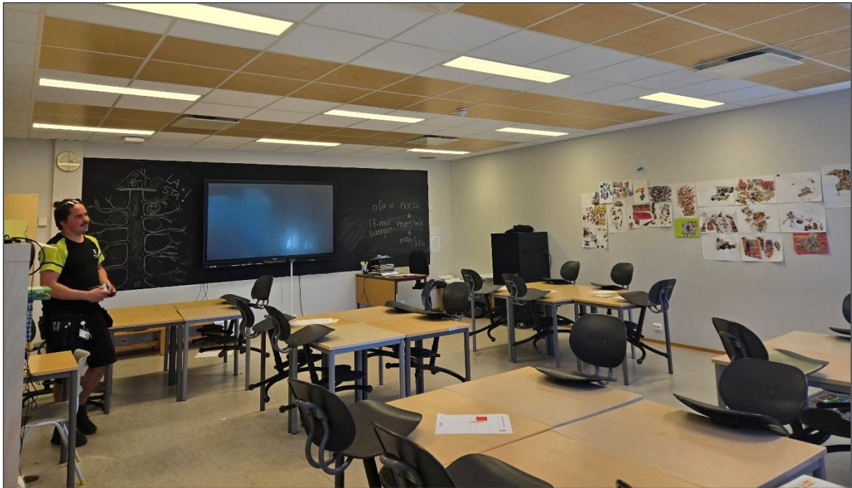
Byggdrifter Mikael Antonsen har skiftet ut lysarmaturer på Botne skole. Foto: Frode Røstvang.
