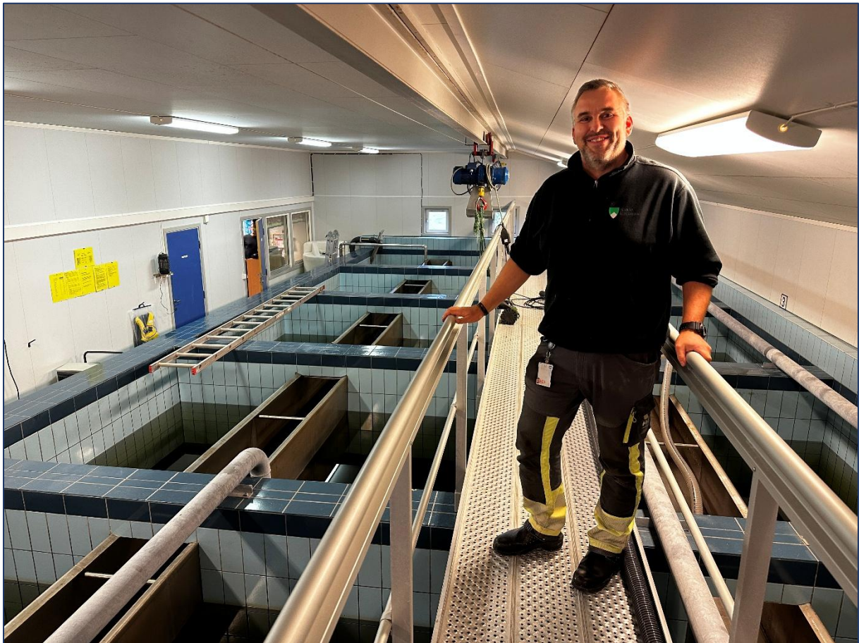
Fagarbeider Niels Suthmann på Seterdammen vannbehandlingsanlegg i Sande. Anlegget er del av vannforsyningen til Blindvannverket IKS. Foto: Anitra Fossum.
