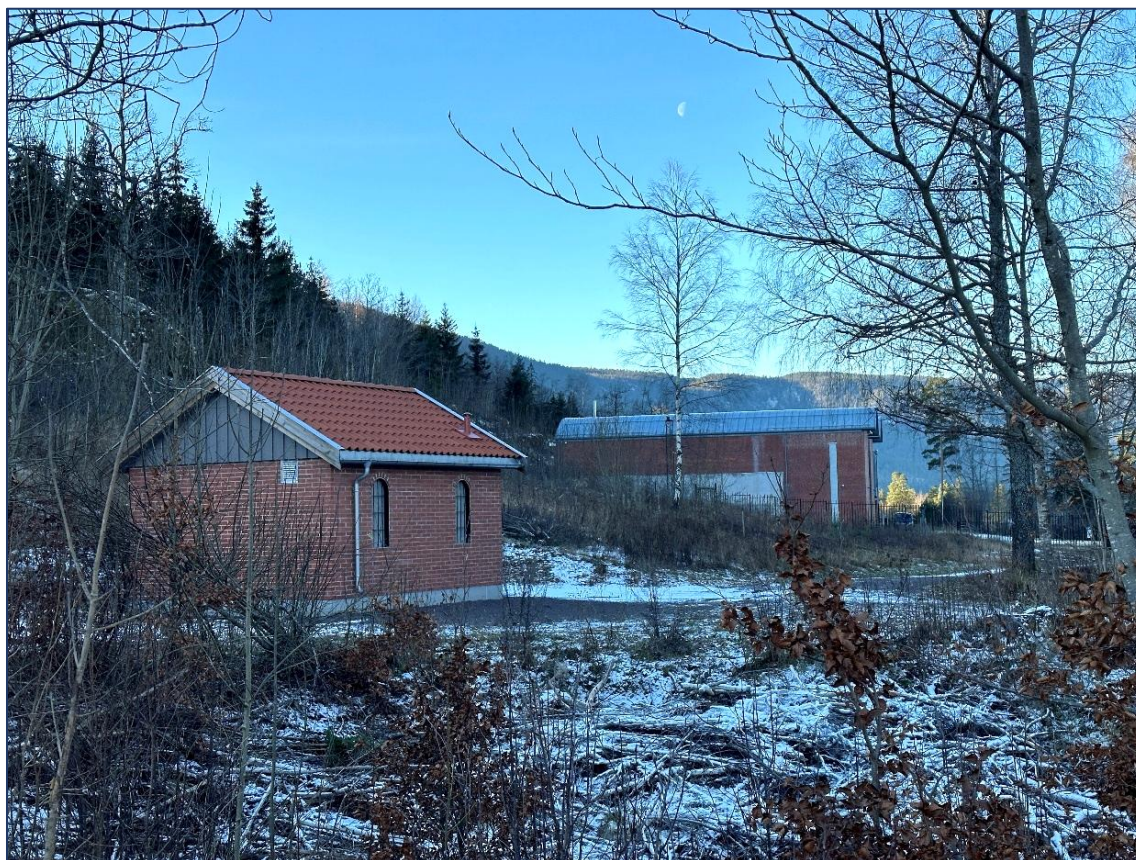
Trykkøkningsstasjonen på Eidsfoss er teglsteinskledd og passer inn i det kulturhistoriske miljøet. Foto: Anitra Fossum.
